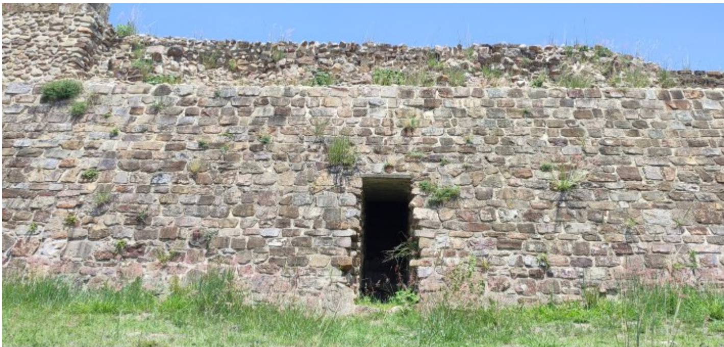
Le palais : probablement à destination des hauts dirigeants ou des prêtres, des couloirs souterrains relient ce bâtiment à d'autres afin de ne pas se dévoiler à la foule.
