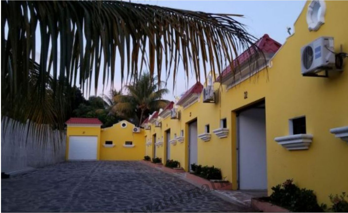
L'entrée d'un auto-motel.
