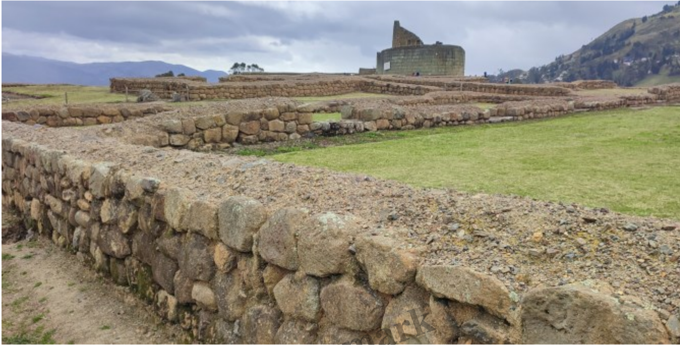
Au premier plan, la technique de construction cañari
