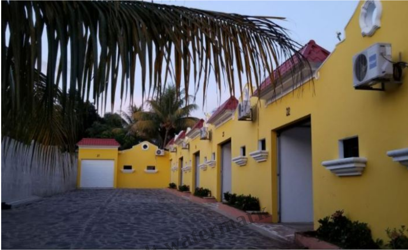
L'entrée d'un auto-motel.
