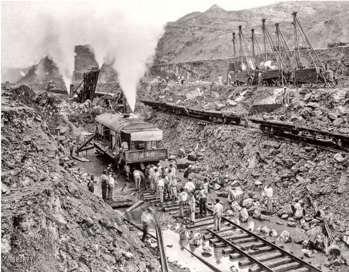
Pour donner une idée du chantier.
